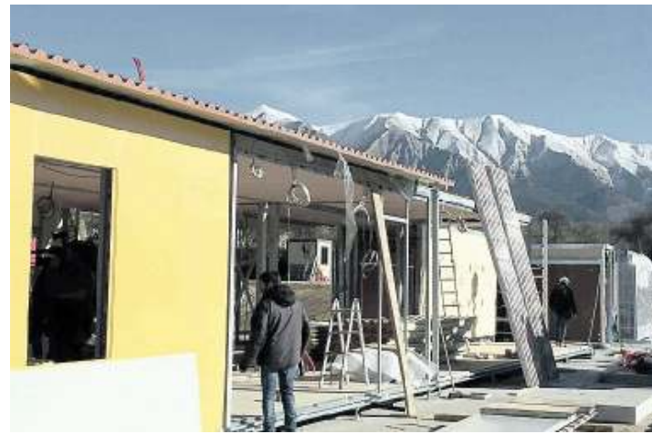
La prima casetta da 80 metri quadri in fase di montaggio
